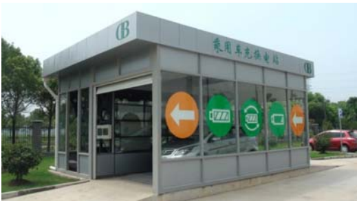
上海电巴公司的小型化换电站 Battery Swapping
